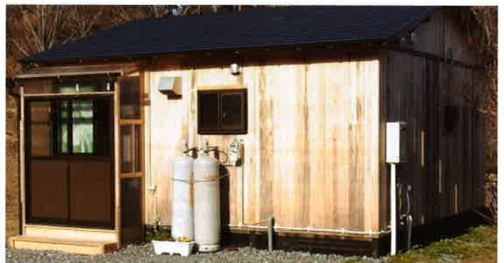
[ 木造戸建て仮設住宅 ]
